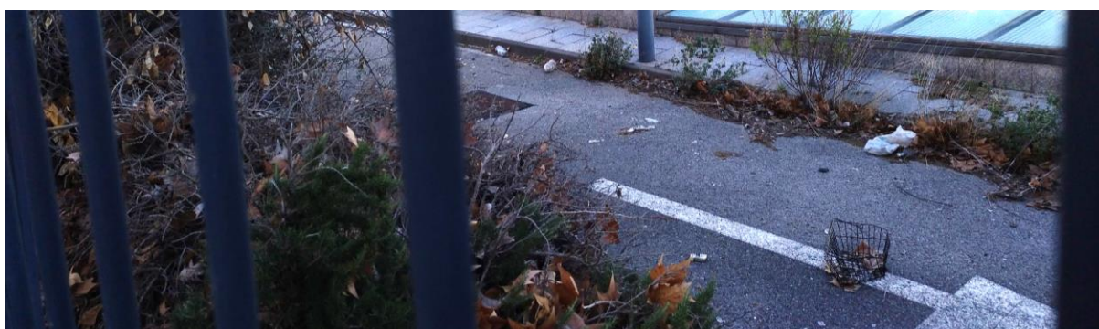
Destrosses a l'interior i a l'exterior de l'edifici Entrada principal a la seu de Caixa Laietana
