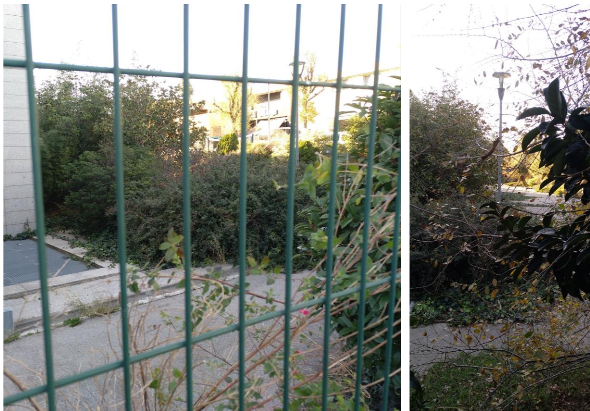
Part posterior de l'edificació
