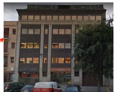
Façana de la biblioteca pública Fundació Iluro
