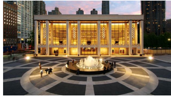
Façana principal del Lincoln Center de Nova York
