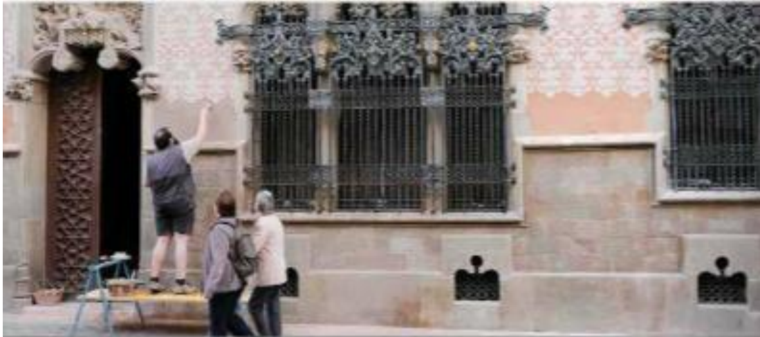
Procés de restauració de la façana
