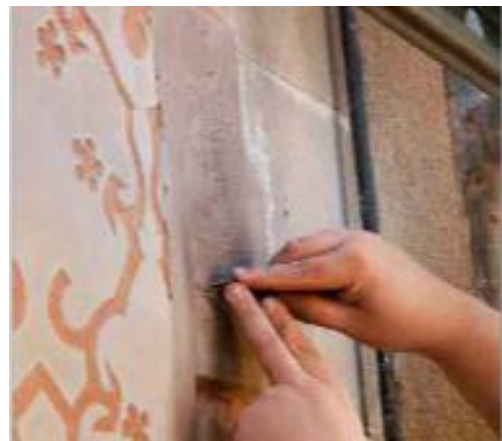
Rehabilitació dels esgrafiats
