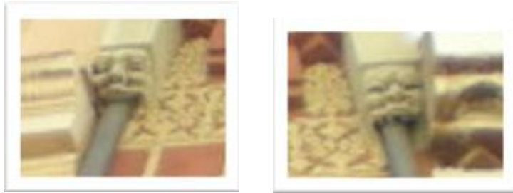
Canonades d'aigua decorades amb màscares de pedra
