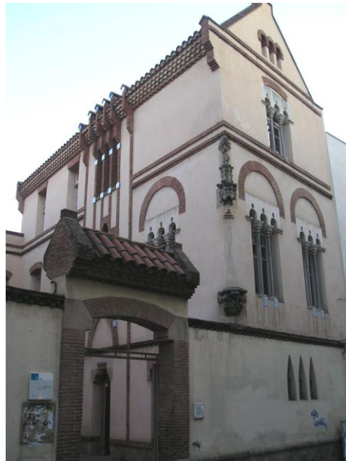
Façana amb els finestrals amb columnes en forma de corol·les
