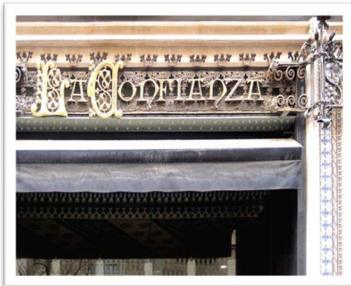
Rètol exterior de ferro forjat
