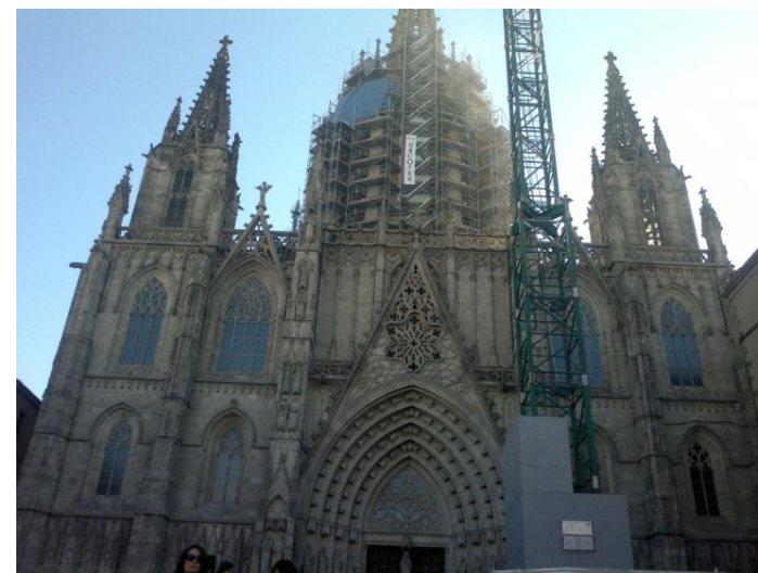
Façana a dia 23/12/11, ja quasi totalment restaurada (pròpia)
