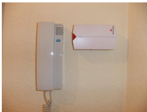
Sistema que va connectat a les llums de la casa i que s'engenen i apaguen al trucar el timbre de la porta.
